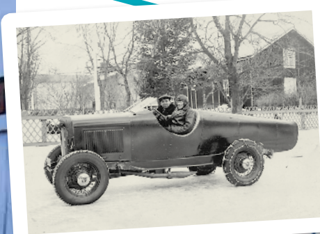
Masonite lämpade sig dåligt för cykelbilsbyggen. I Hobby-Förlagets och Hobbex klassiska ritning till Cykelbilen Fantom nämns inte materialet, man förordar fanér eller duk. Men Lennart Forsberg i Mo använde sig av närproducerad Masonite när han slöjdade fram en boattail deluxe till sin Ford -32 tävlingsbil. Skickligt! Bisittaren från Järnsås (misstänkt lik Ulf Lundell) heter Kalle Nordström.
